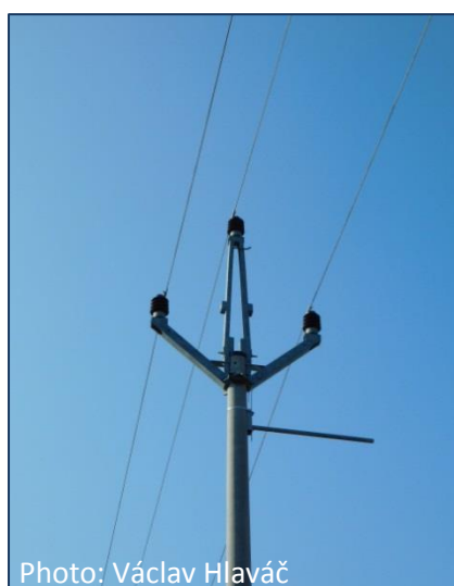
Fig. 19 Console „Pařát“ with a perch
